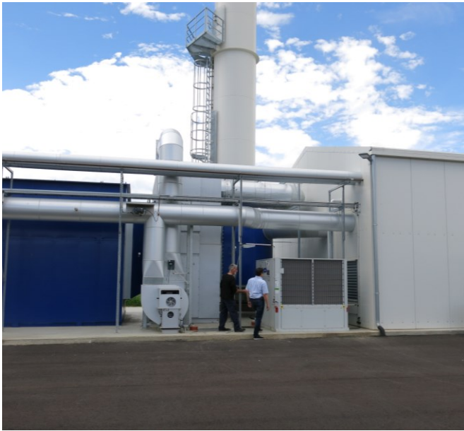
Aufkonzentrierte, mit VOC beladene Lackierabluft wird über die Turbinenanlage gereinigt und zur Strom- und Wärmeproduktion genutzt.
