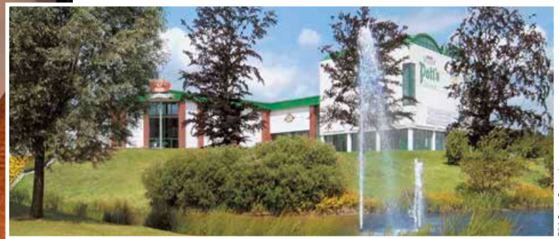
Pott's Brauerei nutzt eine Mikrogasturbine für ihre Energieversorgung
